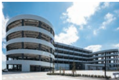
Landport厚木愛川町
