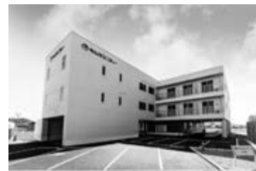
犬山寮新築工事
