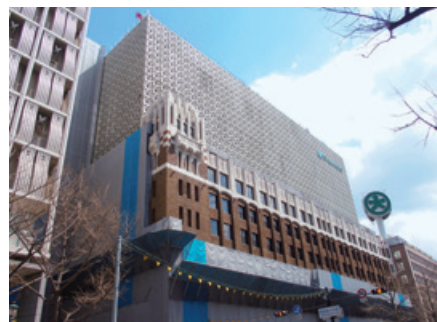
心斎橋店新本館工事中外観
