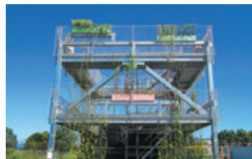
岐阜県にある技術センターの実験棟
