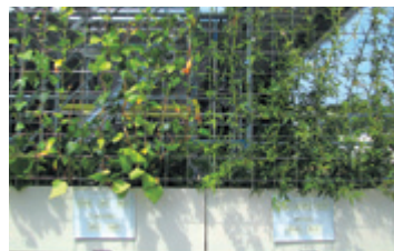
壁面緑化の実験の様子
