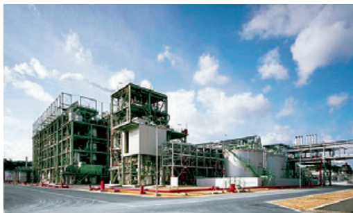
▲MDI製造設備
