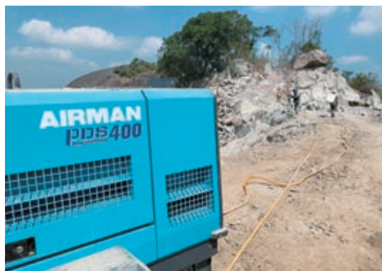
エンジンコンプレッサ 砂利碎石現場
