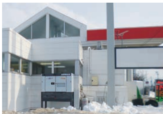
非常用発電機 設置現場
