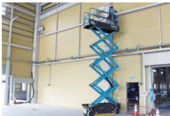
高所作業車 工場内配線・配管工事現場
