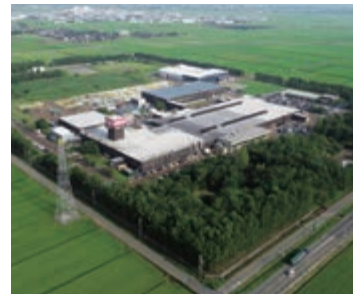
本社・工場全景
