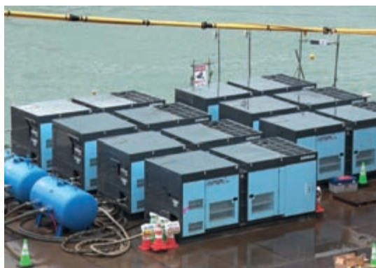
エンジンコンプレッサ 河川工事現場
