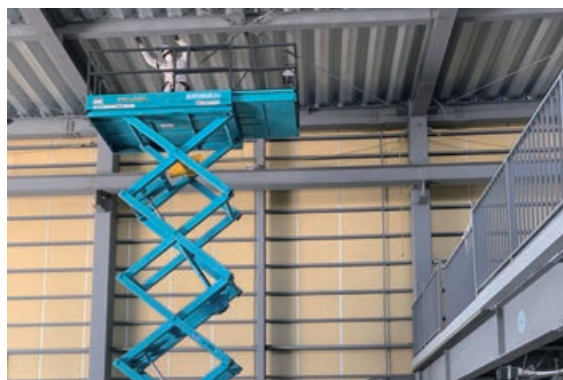
高所作業車 配線・配管作業現場
