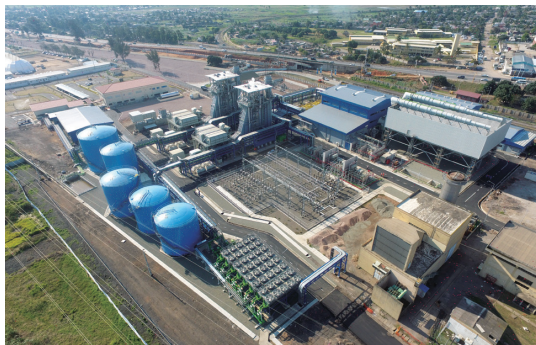
モザンビーク電力公社向けガス焼き複合火力発電所 (提供：モザンビーク電力公社)
