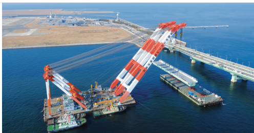
復旧工事の様子
